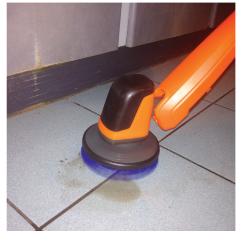
Tegelvloeren en voegen
